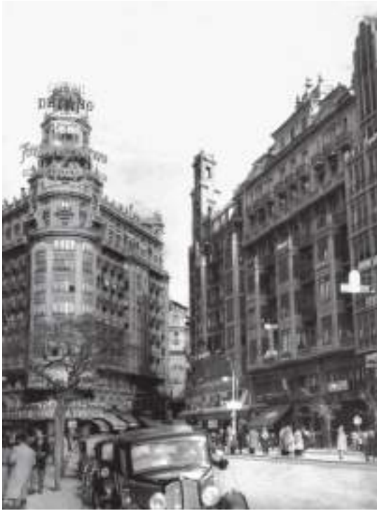
Fig. 1.- Fachada del edificio del estudio de Ferri, sin fecha. Archivo Ferri.
